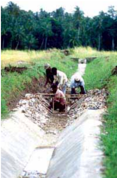
Des ouvriers reconstruisent et revêtent un canal d'irrigation (photo FAO/17563/A.Conti)
