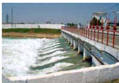
Structure sur le fleuve Chirlik contrôlant le débit du Syr Darya
