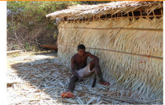
Construire les murs en satrana
