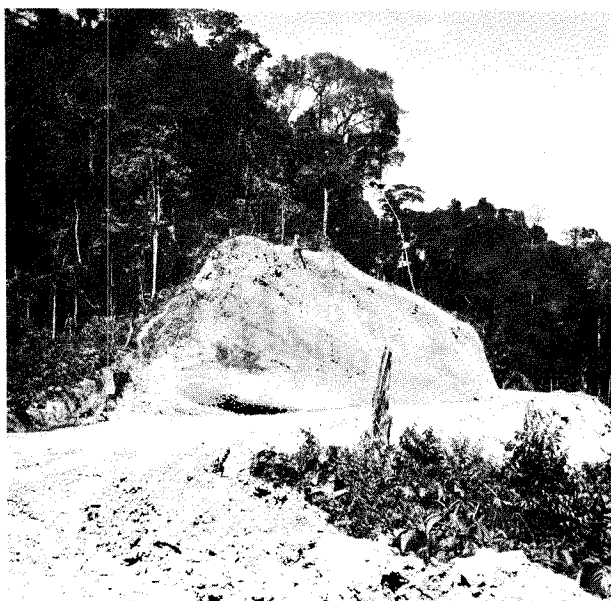
14. Carretera abierta en suelos de la asociación Avispa entre Quincemil y Puerto Carlos, que presentan los efectos de una erosión profunda y arenas graviscosas, inadecuados para la agricultura.
