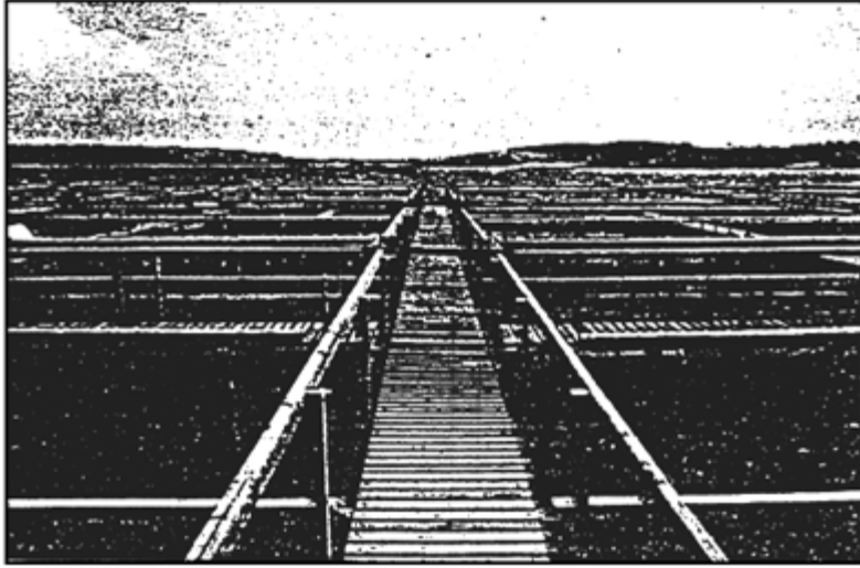
Cliché № 4: PONTON DE CIRCULATION
