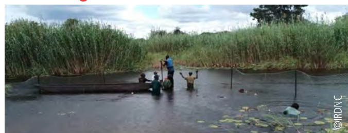
Installation d'une clôture anti-crocodiles dans l'aire de conservation de Balyerwa.
