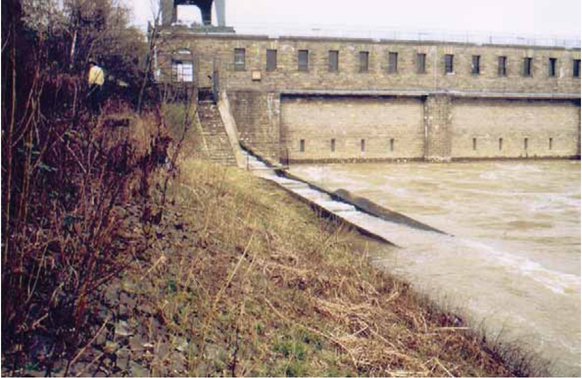
Şekil 5.11: Koblenz/Moselle balık geçidi (mansaptan görünüş)
