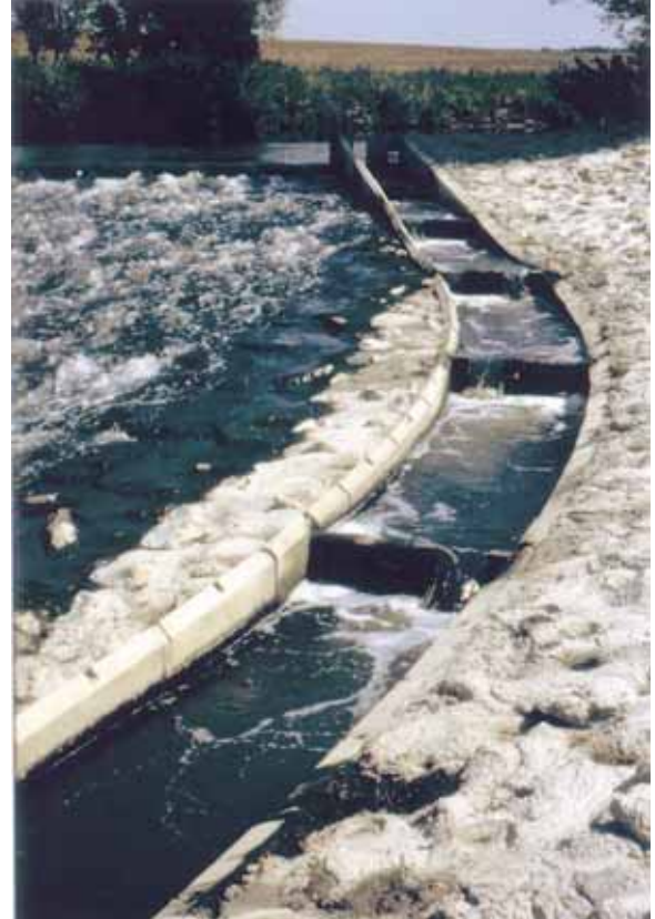
Şekil 5.13: İşletmedeki Dahl havuzlu geçidi (mansaptan görünüş)
