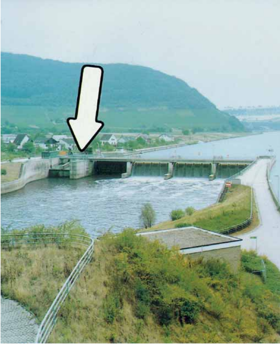
Şekil 5.44: Schoden/Saar balık eklüzü (önden görünüş)
