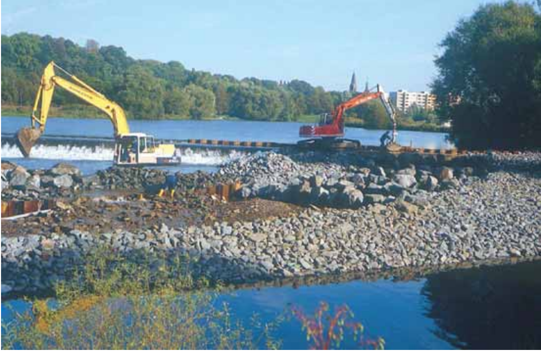
Şekil 4.40: Spillenburg bendi; inşa hâlindeki balık rampası
