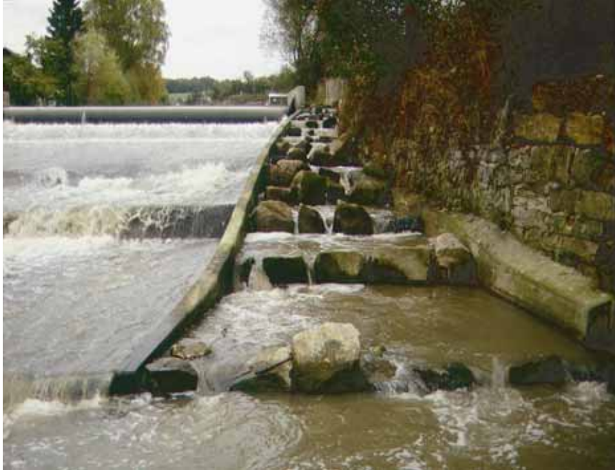
Şekil 4.37: Pürüzlü kanallı Uhingen/Fils havuzlu geçidi Mansaptan görünüş
