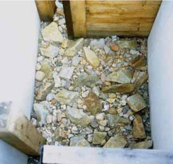
Şekil 3.14: Yarıklı geçitte kaba malzemeli substrat; Unterspreewald'deki (Brandenburg) Aşağı Puhlstrom bendi
