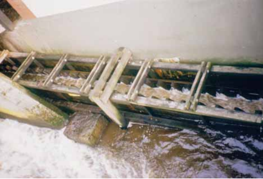
Şekil 5.30: Gifhorn/Ise'de ahşaptan yapılmış Denil geçidi (Aşağı Saksonya)
