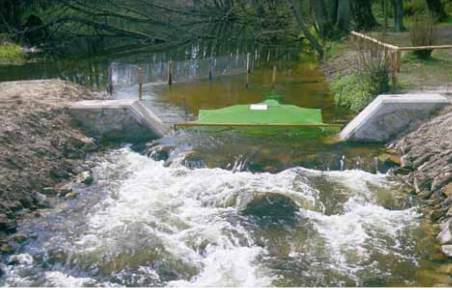
Şekil 6.1: Stöbber'deki (Brandenburg) Pritzhagener Değirmeninde bulunan balık rampasının işlevselliğinin izlenmesi için yapılan balık tuzaklaması
