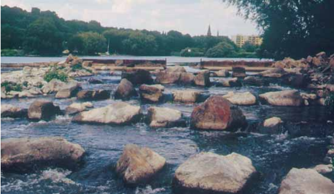
Şekil 4.41: Spillenburg bendi; balık rampasının inşaat tamamlandıktan sonraki görünüşü
