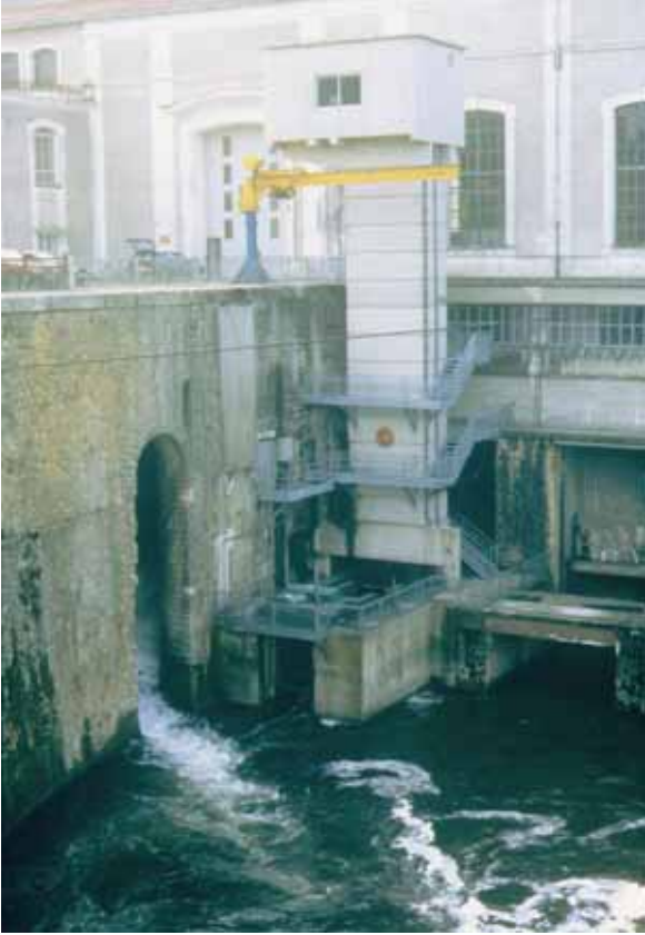
Şekil 5.46: Tuilières balık asansörü. Asansör, türbin çıkışların hemen yanında sağ tarafta bulunmakta olup, balıkları 10 m yükseklikteki ara havuza taşımaktadır; geriye kalan 2 m'lik yükseklik farkı ise yarıklı geçitle aşılmaktadır.
