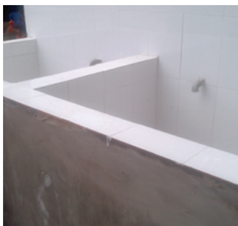
Réservoirs d'immersion pour nettoyer et désinfecter les cages de transport.
