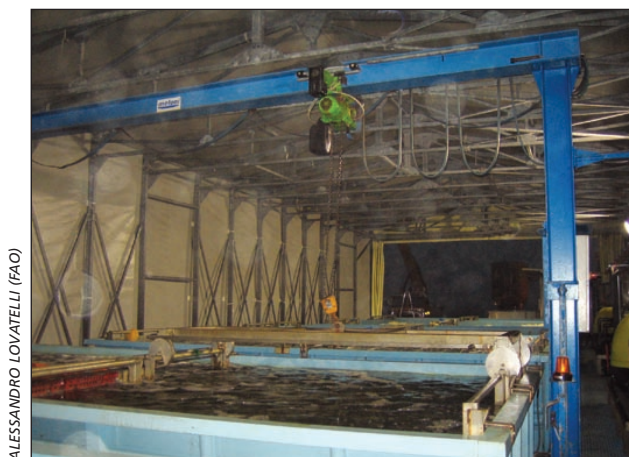
Figure 8.1: Système mécanique de chargement et de déchargement des bassins
