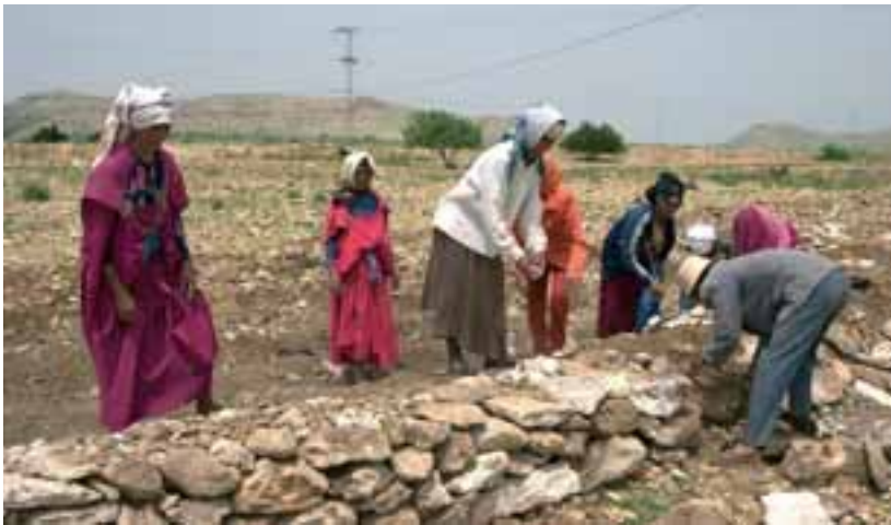
Alcuni partecipanti al programma costruiscono un argine in pietra per intercettare l'acqua di scorrimento e farla penetrare nel suolo perché non si perda.
