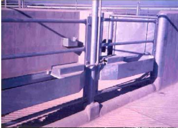
Зураг 22: Төмөр хөндлөвч, бетонон ханаар хэсэглэж хуваасан хашаа
