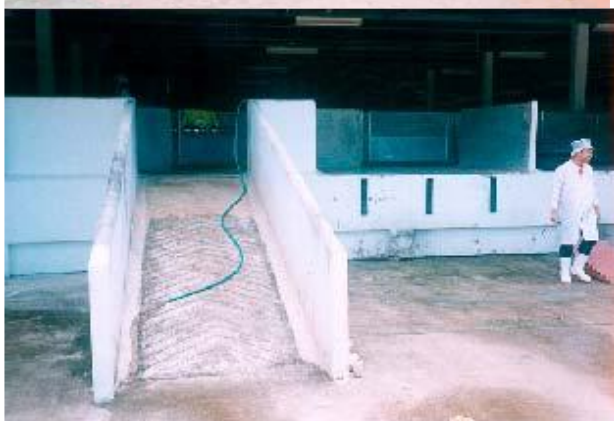
Зураг 16: Тээврийн хэрэгслээс гахайг буулгах тавцан, хашаанд оруулах налуу шат
