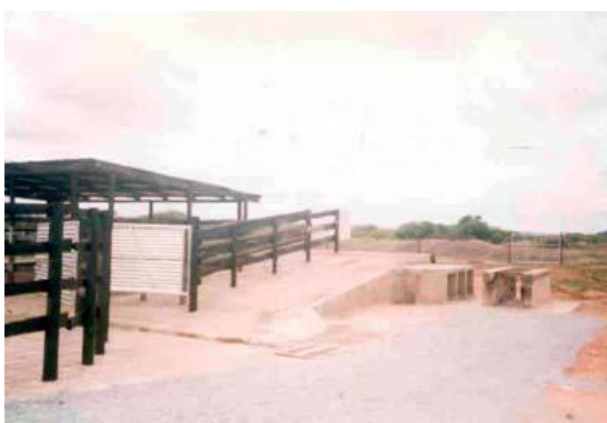
Зураг 15: Тээврийн хэрэгслээс үхэр буулгах, ачих, байлгах зориулалттай сайтар төлөвлөж барьсан хашаа /тавцан
