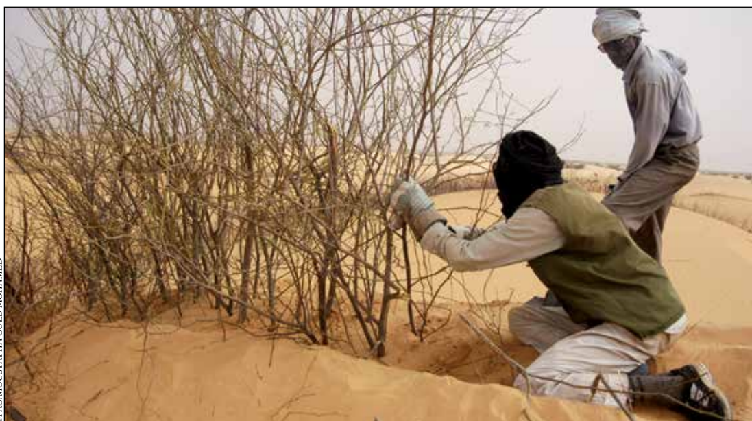
Installation d'une palissade, stabilisation mécanique des dunes, Mauritanie
