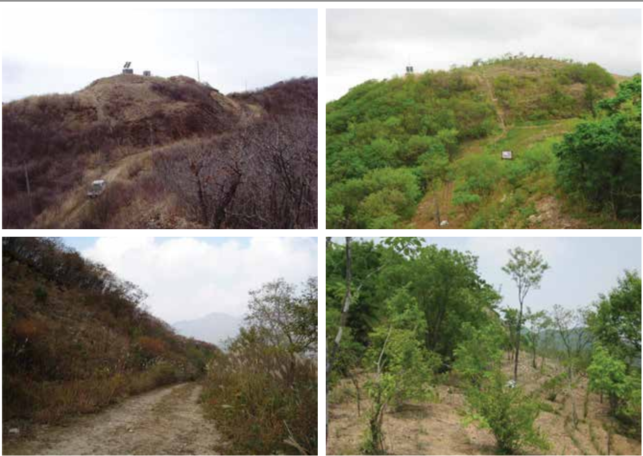
6 Restauration d'une base militaire abandonnée et de routes d'accès à Baramjae (à gauche: avant la restauration; à droite: après la restauration)
