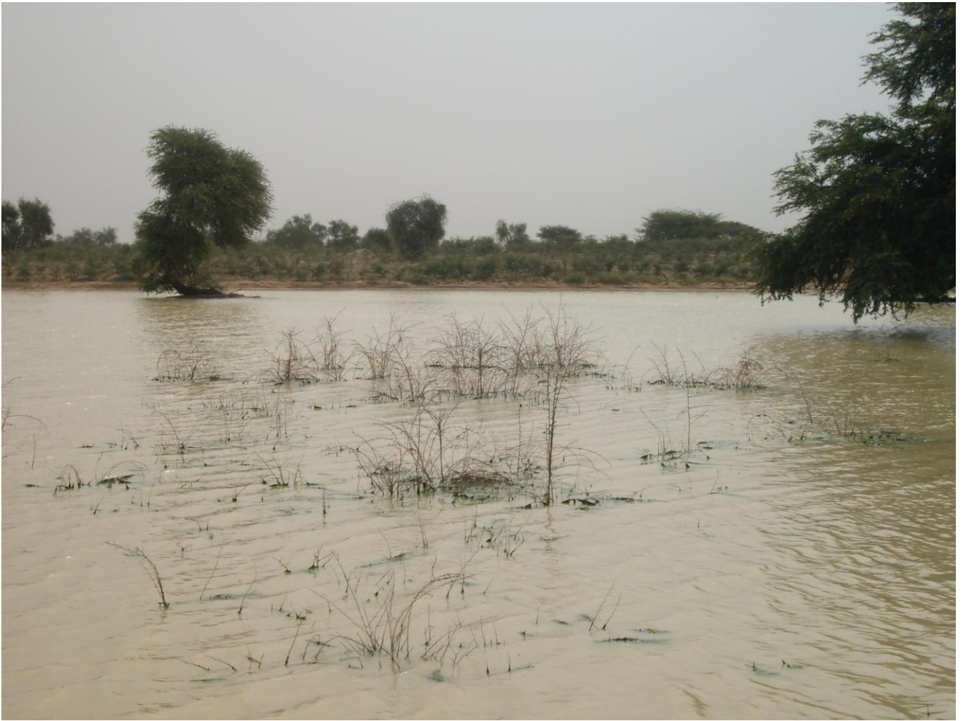
Bassin de rétention réalisé à Labgar en 2009, avec reboisement des berges pour la protection
