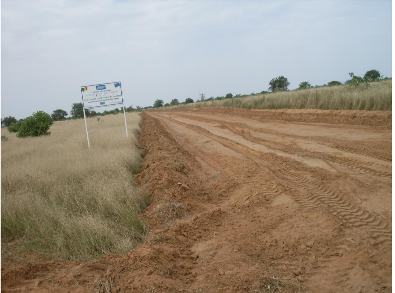
Pare feu entre Widou Thiengoly et Tésékéré sur 30 km de long
