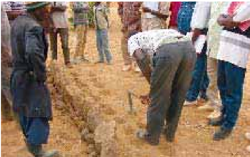
Pose collective de rangées de pierres.
