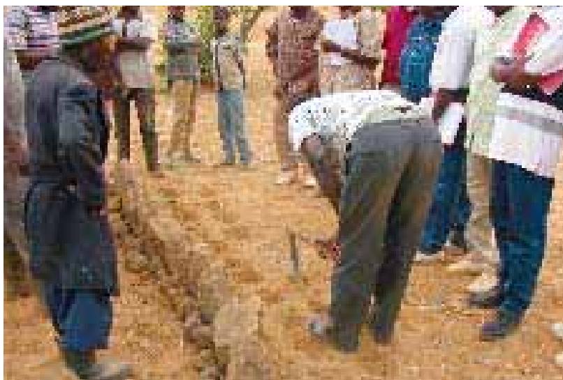
Tendido de filas de piedra comunales.
