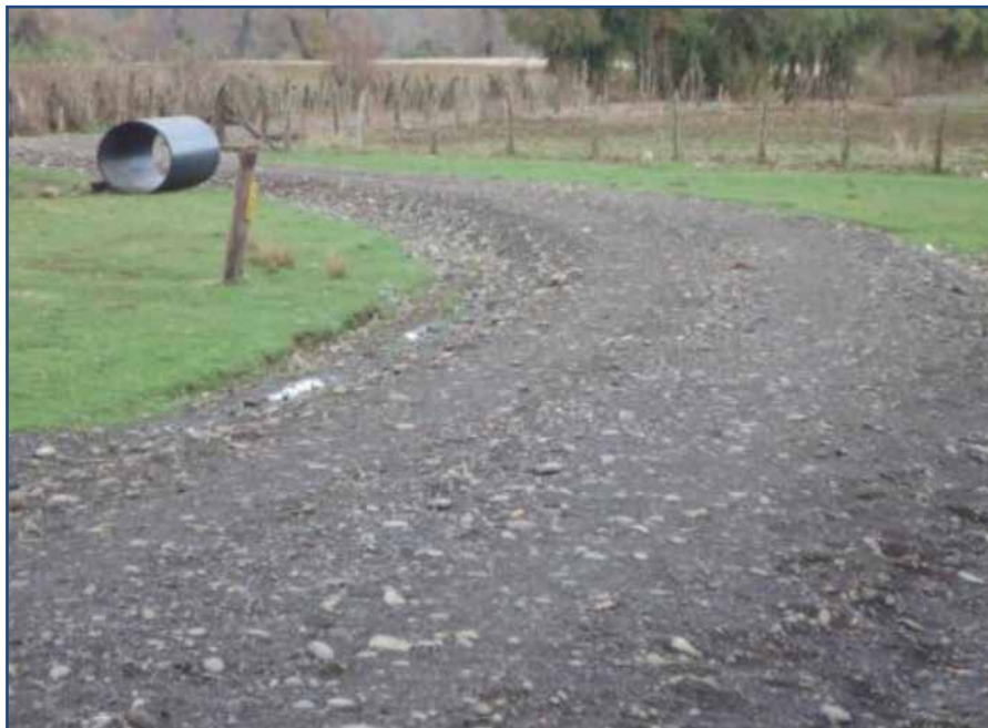
Imagen N° 5 Vista camino comunitario principal y puente existente comunidad Ancao Ancatén, Junio 2011.
