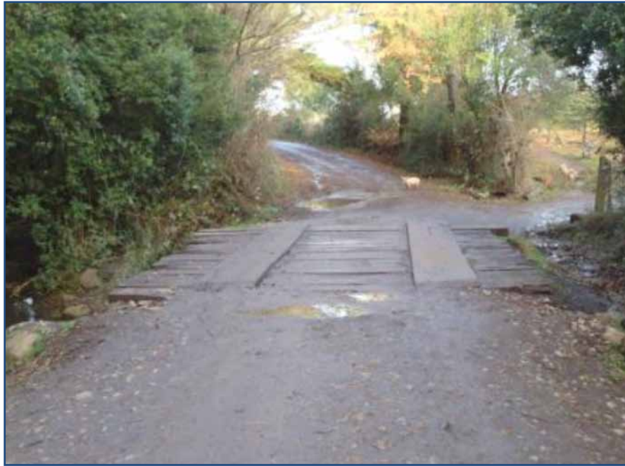
Imagen N° 4 Vista camino comunitario principal y puente existente comunidad Ancao Ancatén, Junio 2011.
