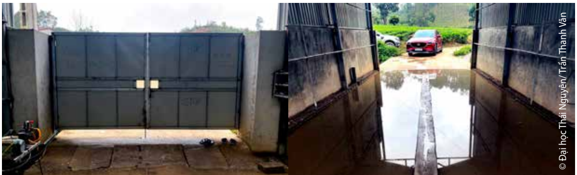
Hình 44. Hệ thống khử trùng ở cổng trại
