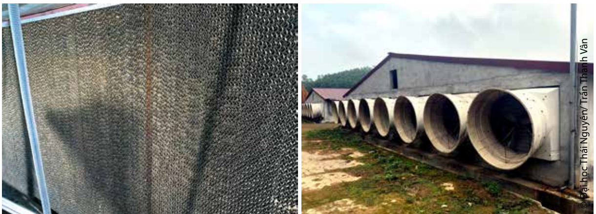
Hình 24. Tấm làm mát (trái), quạt hút (phải) lắp đặt ở chuồng kín nuôi gà
