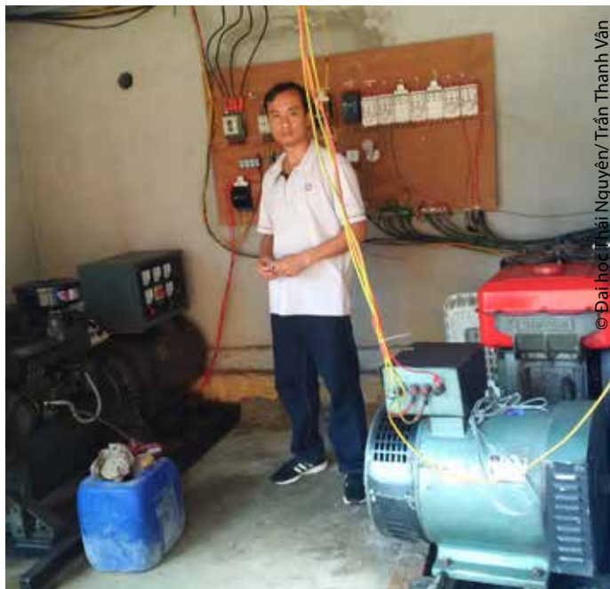
Hình 38. Luôn có hai máy phát điện tại trại gà thịt nuôi trong chuồng kín
