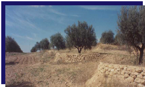
Figure 1 : Ouvrages de rétention d'eau dans une oliveraie en région semi-aride, confectionnés par les bénéficiaires dans le cadre d'une approche participative. (Projet GCP/TUN/028/ITA)
