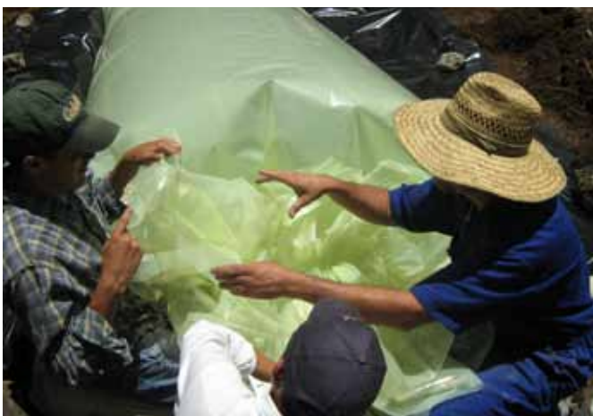
Construcción de biodigestores
