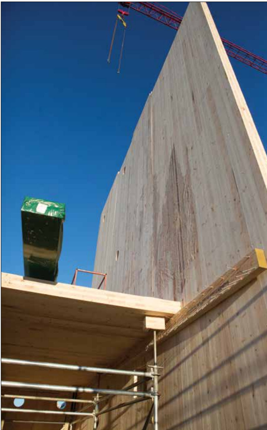
Construction du Wood Innovation and Design Centre à Prince George, Canada, le plus haut édifice contemporain en bois d'Amérique du Nord, de 29,5 mètres de haut (six étages plus terrasses)
