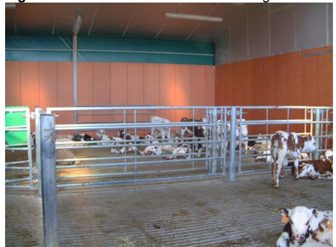
Figure 5 : box collectif – sol caillebotis intégral
