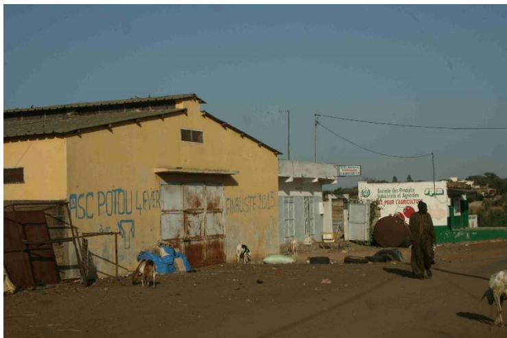
Potou. Magasin de stockage fermé (aération insuffisante).
