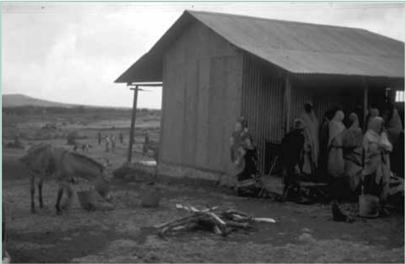
FIGURA 17 Construcción de acero galvanizado para molino de martillos rural en Kenya.
